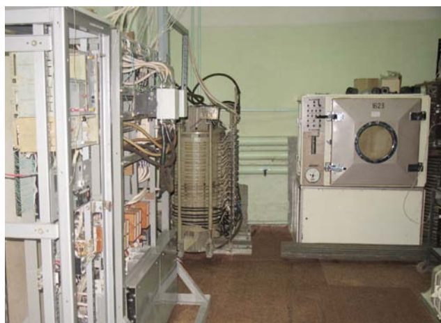
» Лаборатория коммутационных испытаний
